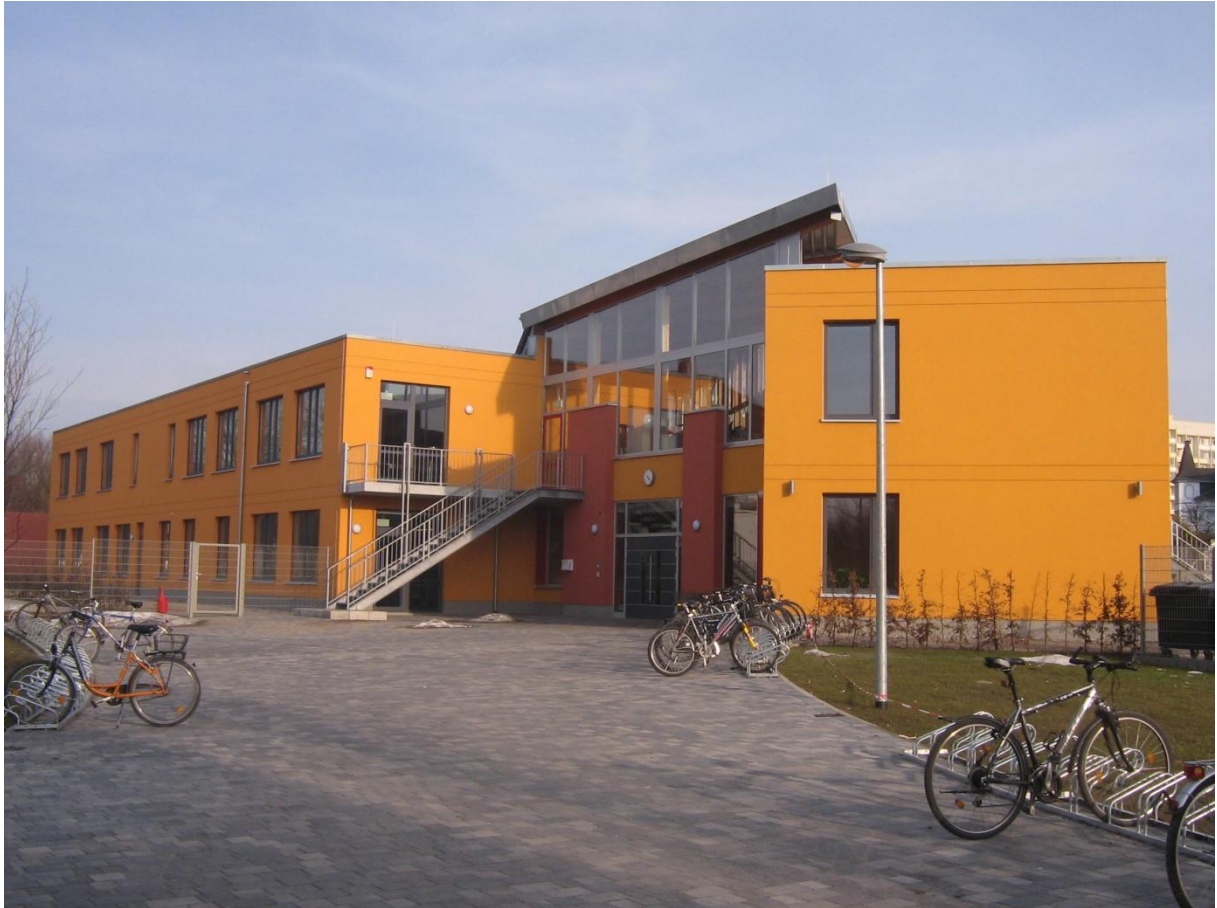
Haus 4 Ansicht Nordwest Haupteingang
