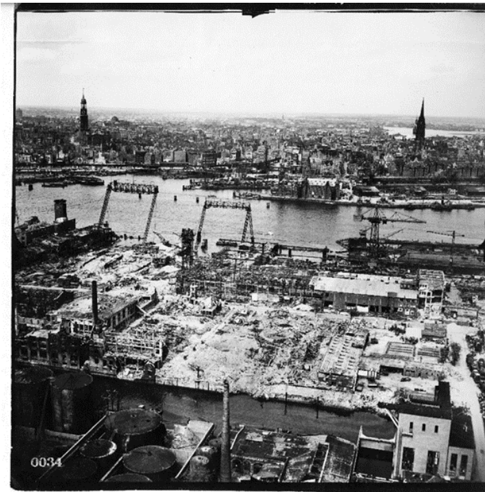
Abbildung 1: Luftbild mit Zerstörungen im Hamburger Hafengebiet, Quelle: Feuerwehr Freie und Hansestadt Hamburg
