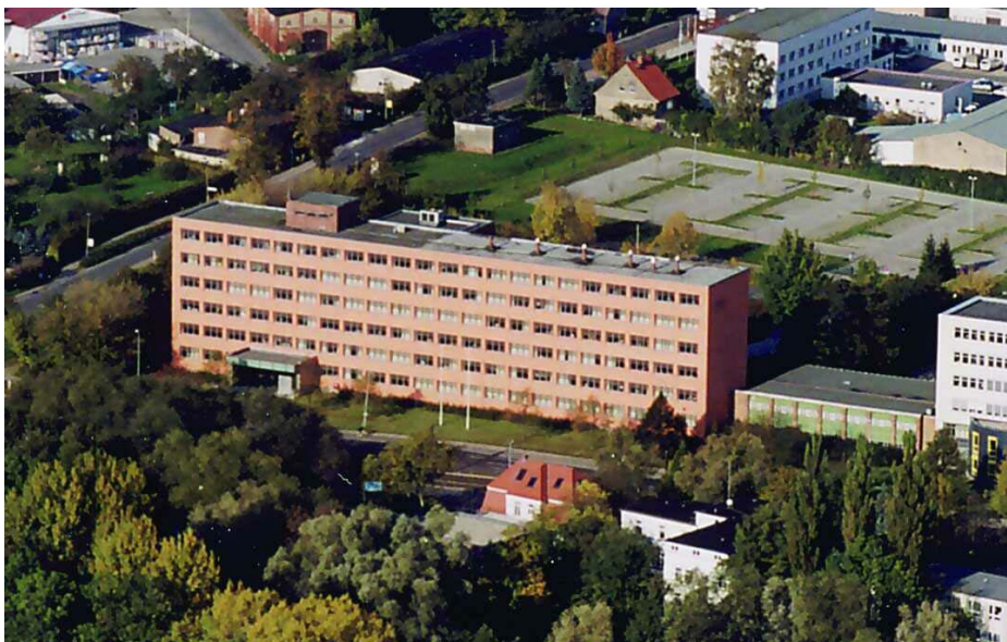
Dienstgebäude des Landesvermessungsamtes Mecklenburg-Vorpommern
